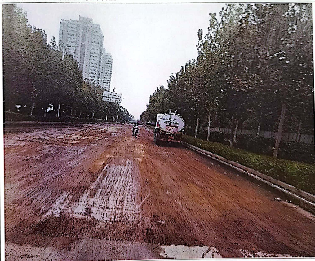
人民路施工洒水降尘
