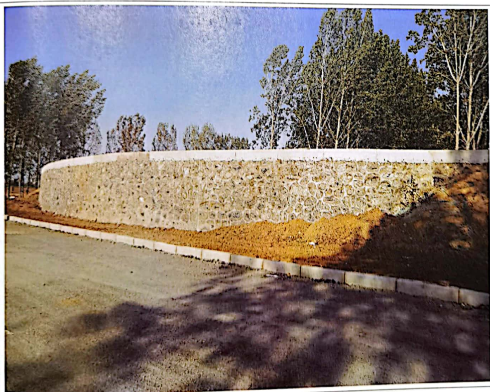
半坡弯道周边挡土墙
