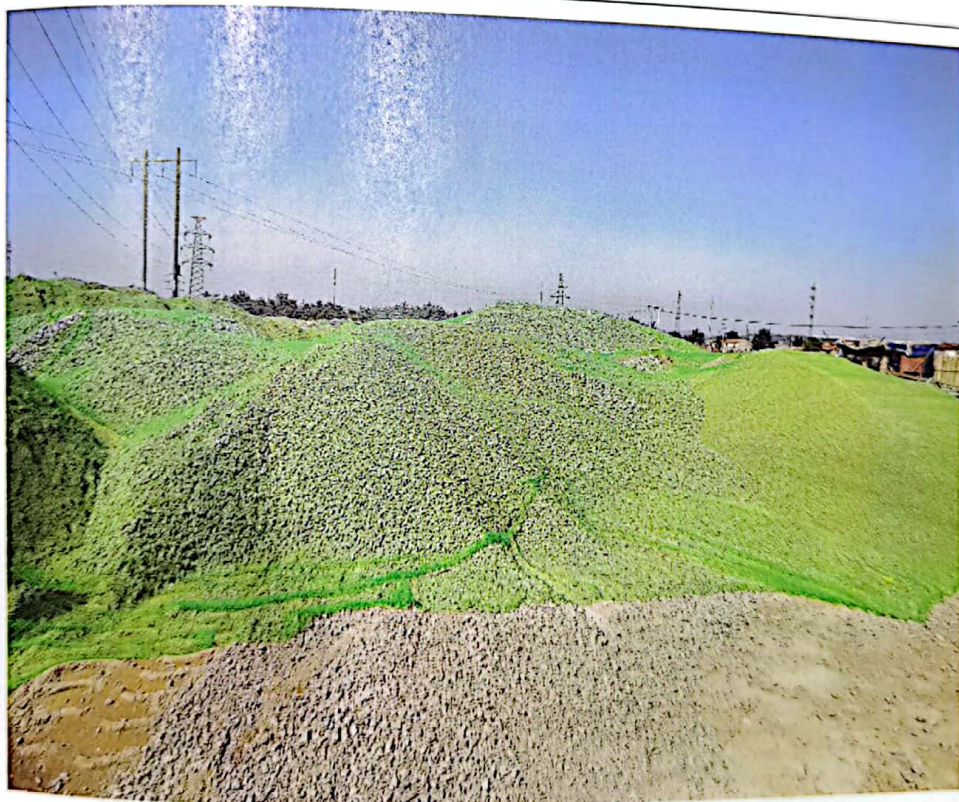
建筑砂石料临时苦盖
