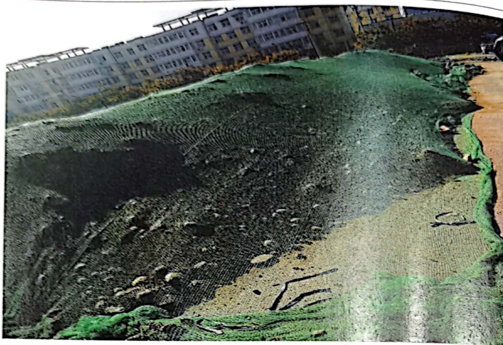
七、马村停保场施工过程中水土保持措施照片
